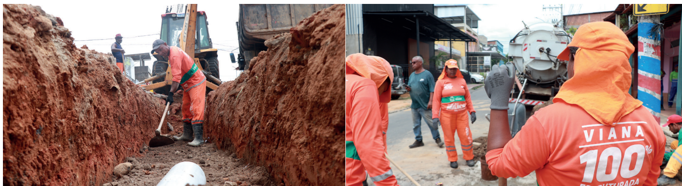
Obras de Macrodrenagem do Programa Minha Rua Melhor. FOTOS: Victor Almeida.
